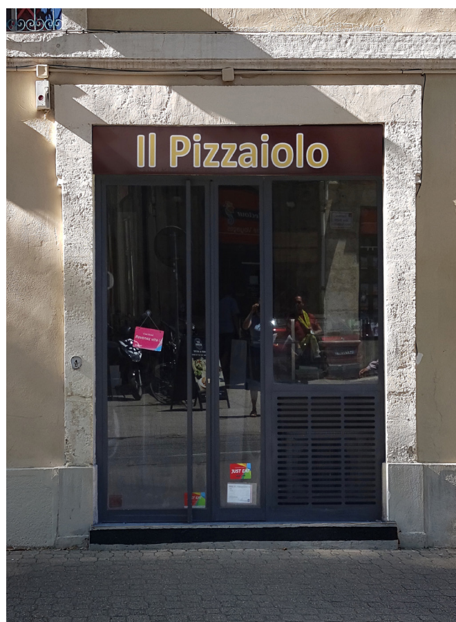
Un encadrement de baie constitue un décor de façade qui participe à la composition d'ensemble. La devanture vient se glisser dans le tableau. Les informations commerciales ne sortent pas de l'encadrement.
