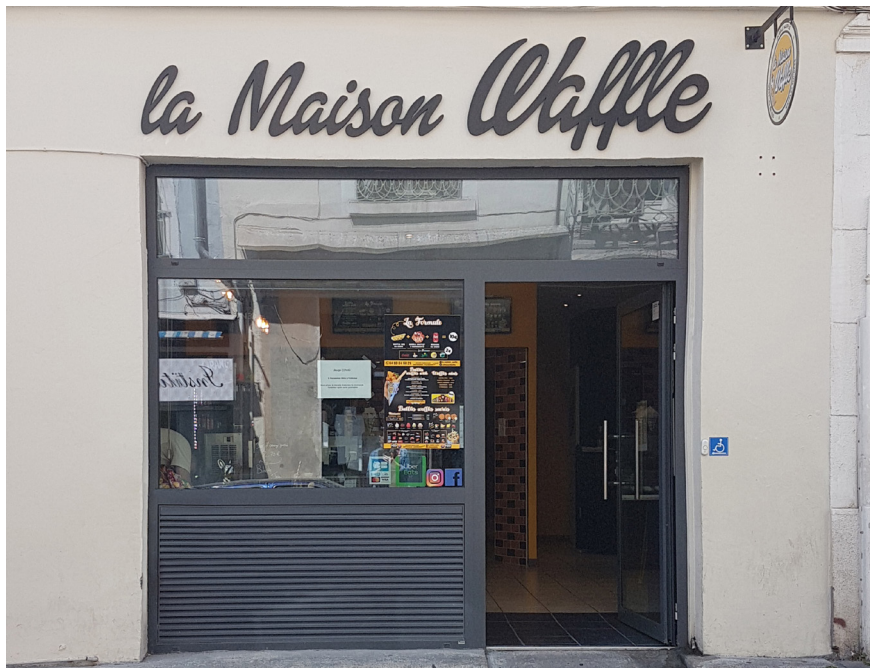
Exemple d'emplacement en soubassement des blocs de climatisation. Les panneaux persiennés deviennent un motif de traitement de la façade.
