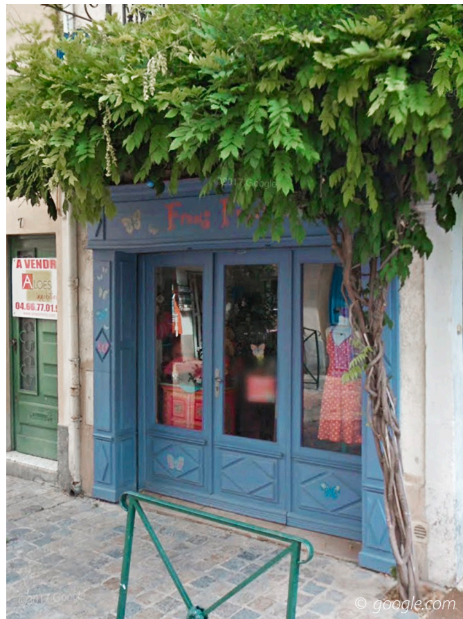
Une glycine couronne l'entablement de la devanture en applique. Le traitement de sol intègre une petite fosse de plantation pour la plante grimpante.
