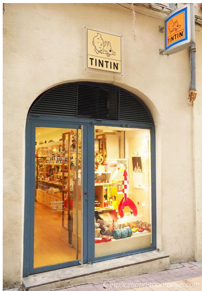
Exemple d'une devanture métallique dont la couleur et la forme s'intègrent harmonieusement avec l'édifice où elle prend place.
