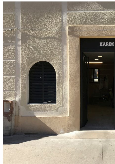
Le bloc de climatisation peut être placé derrière un volet en persienne d'une fenêtre condamnée.
