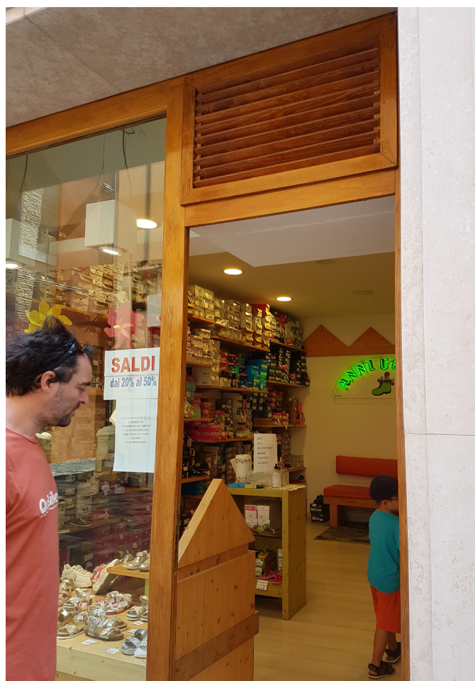
Exemple d'une devanture en tableau en bois. Dans un souci d'harmonie, le bois a également été privilégié pour les ventelles qui permettent l'intégration du groupe de climatisation au niveau de l'imposte de la porte.
