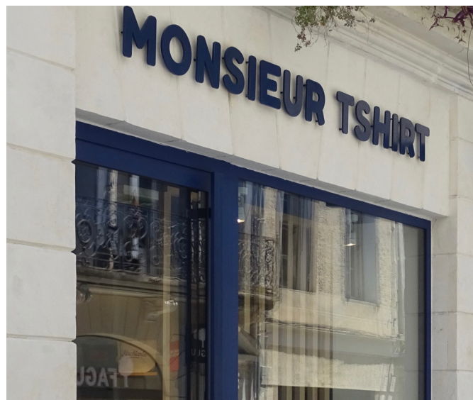
Enseigne en lettres découpées fixées directement au linteau.
