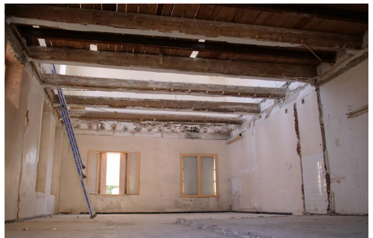
Travaux intérieurs du futur centre socio-culturel
