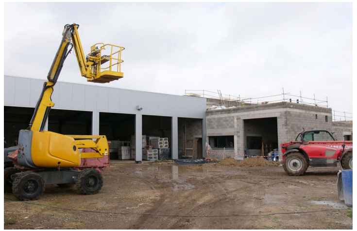
Avancement du chantier de la nouvelle caserne
