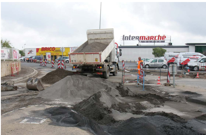
Nouveaux travaux à la Grange Basse
