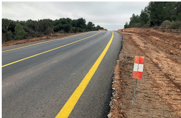
L'élargissement de la route de Coussergues avance
