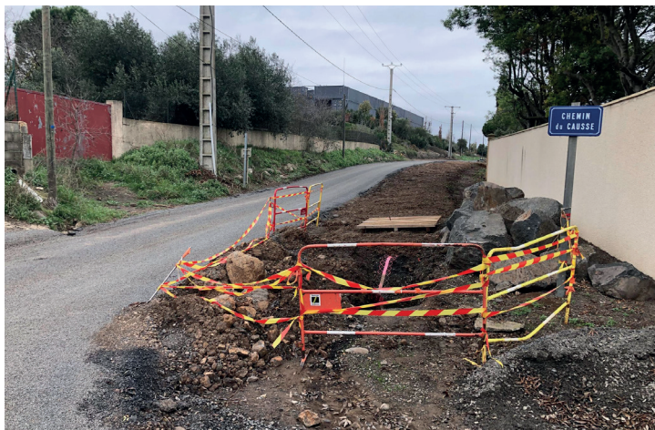
Avancée de l'aménagement du chemin du Causse
