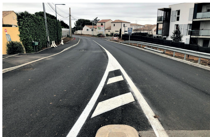
Finalisation de l'entrée de ville route de Béziers
