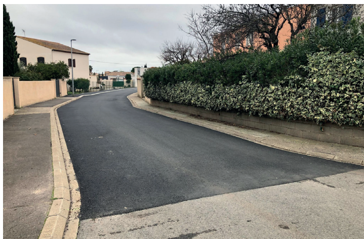
Carrefour sécurisé au chemin de Sainte-Véziane
