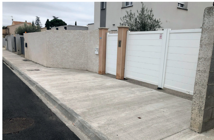
Réalisation de trottoirs au chemin des Ânes
